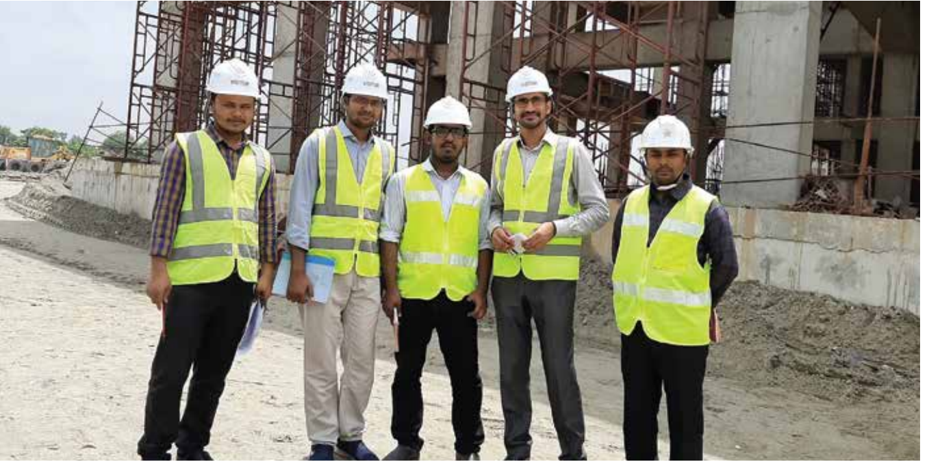
গত ২২ জুন ২০১৯ তারিখ সহকারী প্রকৌশলী কর্তৃক ট্রেন ড্রাইভিং রুমের কাজের অগ্রগত পর্যবেক্ষণ
