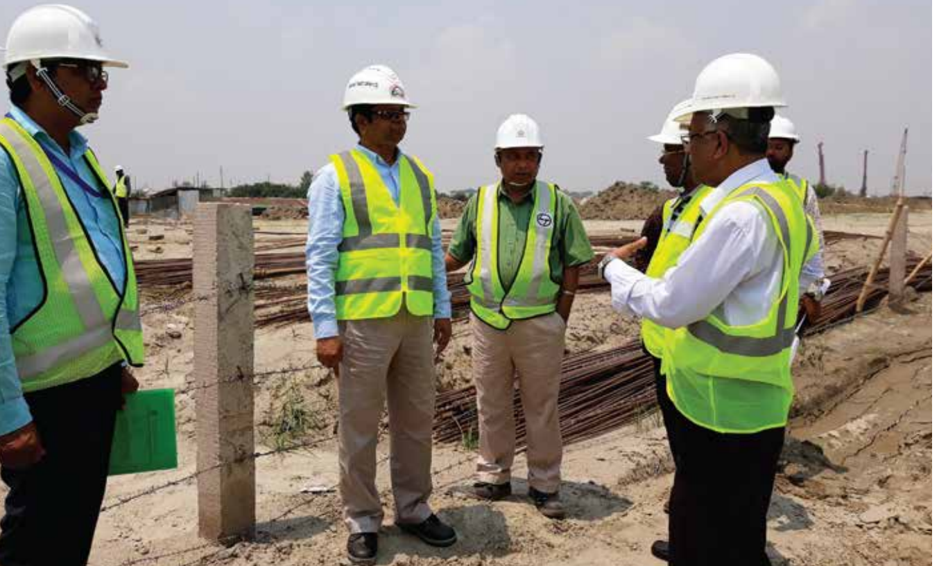
গত ২০ এপ্রিল ২০১৯ তারিখ প্রকল্প পরিচালক, এমআরটি লাইন-৬ উত্তরা ডিপো এলাকার কন্সট্রাকশন ইয়ার্ড পরিদর্শন করেন
