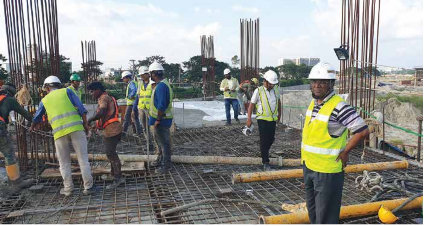
গত ০৮ ফেব্রুয়ারি ২০১৯ তারিখ প্রকল্প ব্যবস্থাপক-৪, MRT Line-6 উত্তরাস্থ রিসিভিং সাব-স্টেশন ভবনের First Floor-এর Slab Casting-এর কাজ পরিদর্শন করেন
