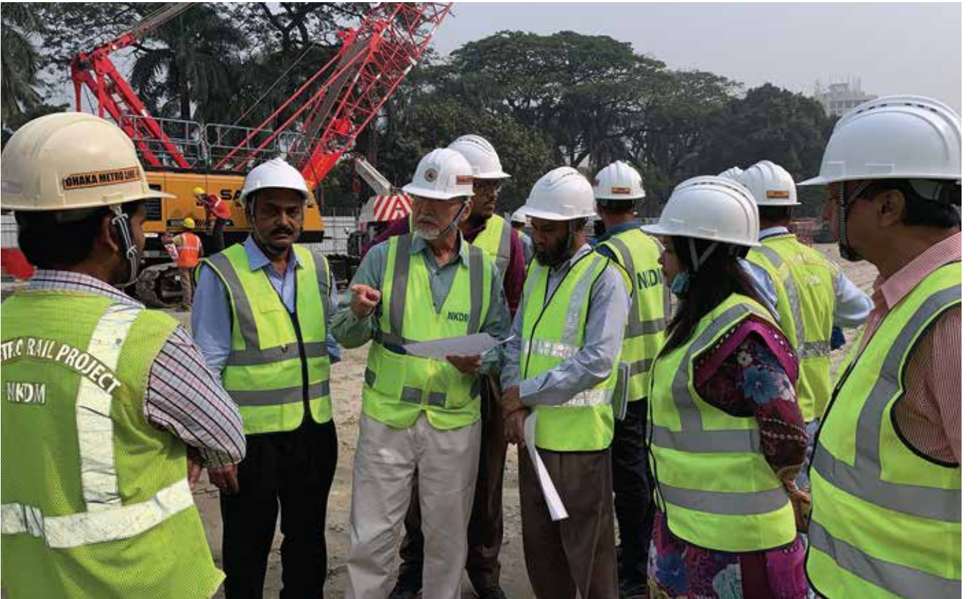
গত ১৫ নভেম্বর ২০১৮ তারিখ প্রকল্প ব্যবস্থাপক-৩, MRT Line-6 ফার্মগেট এলাকায় সাইট প্রস্তুতকরণ কাজ পরিদর্শন করেন
