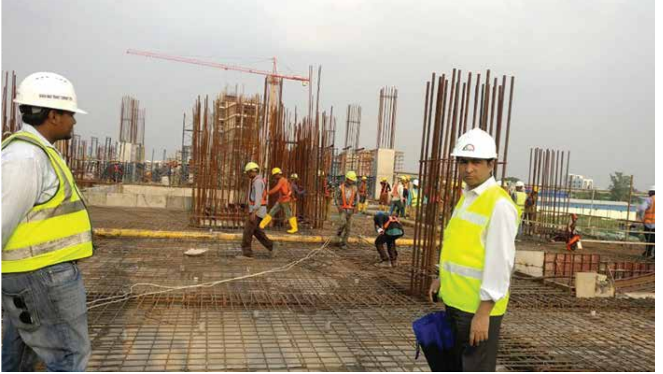
প্রকল্প ব্যবস্থাপক-১, MRT Line-6 কর্তৃক উত্তরা ডিপো এলাকায় ভবন-৩২ এর স্লাব কাস্টিং এর কাজ পরিদর্শন
