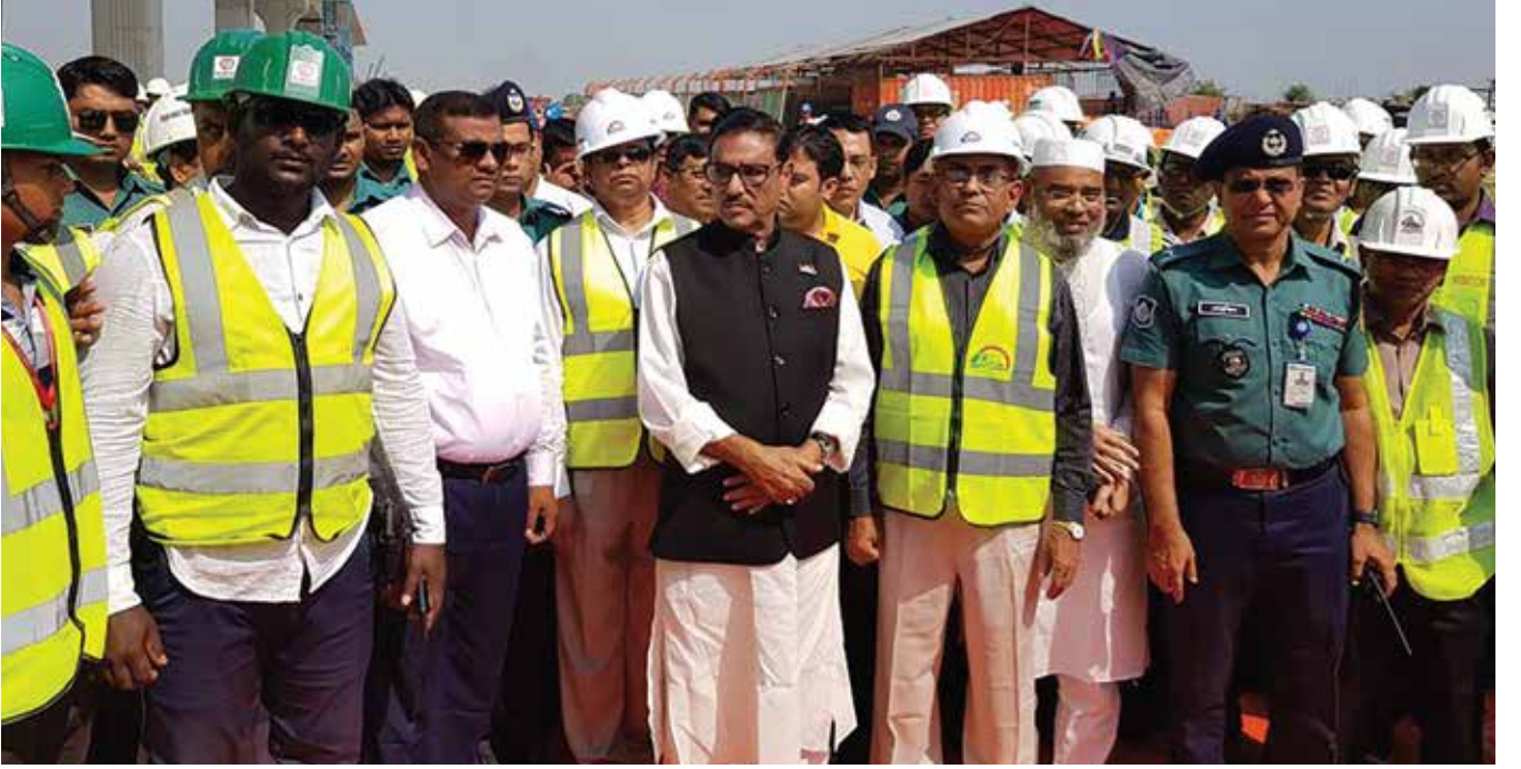
মাননীয় মন্ত্রী সড়ক পরিবহন ও সেতু মন্ত্রণালয় মেট্রোরেলের ভায়াডাক্ট erection কাজের অগ্রগতি পরিদর্শন করছেন
