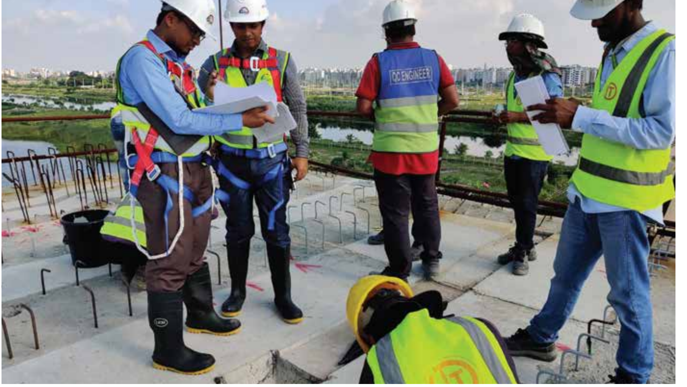
সহকারী প্রকৌশলীগণ কর্তৃক নির্মিত Viaduct এর উপরের অংশ পর্যবেক্ষণ
