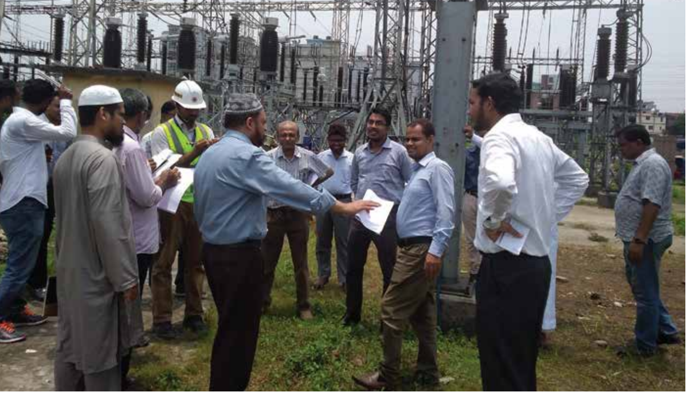
গত ১৮ জুন ২০১৯ তারিখ সহকারী প্রকৌশলীগণ টঙ্গী গ্রিড সাবস্টেশনে ১৩২কেভি বে নির্মাণের অগ্রগতি পর্যবেক্ষণ করেন
