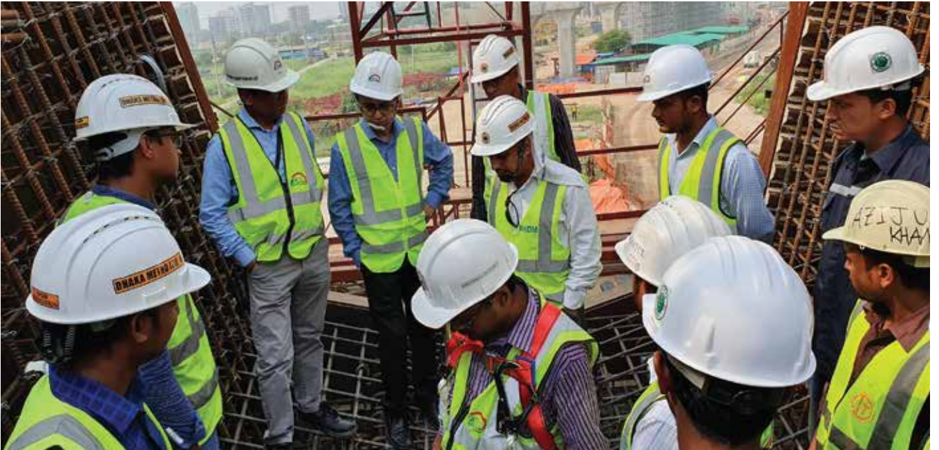
গত ১৯ জুন ২০১৯ তারিখ প্রকল্প ব্যবস্থাপক-২ MRT Line-6 এর Pier-42 এর Cast-in-situ Pier Table of Balamex Cantilever পরিদর্শন করেন
